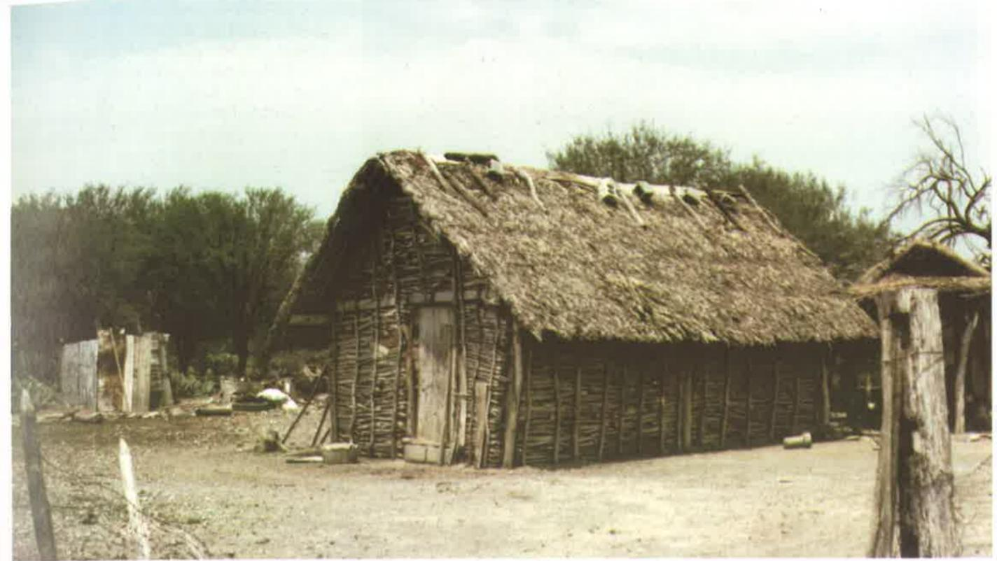
Jacal de bajareque, con muros de palizadas cubiertas de lodo y bañiga, con techo de dos aguas de palma y caña
