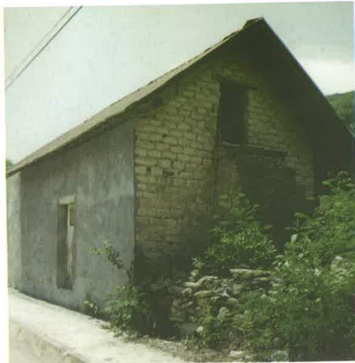
Construcción de adobe con techo de carrizo, similar a la anterior, pero el techo ha sido cubierto con lámina galvanizada y la escalera exterior construida de adobe
